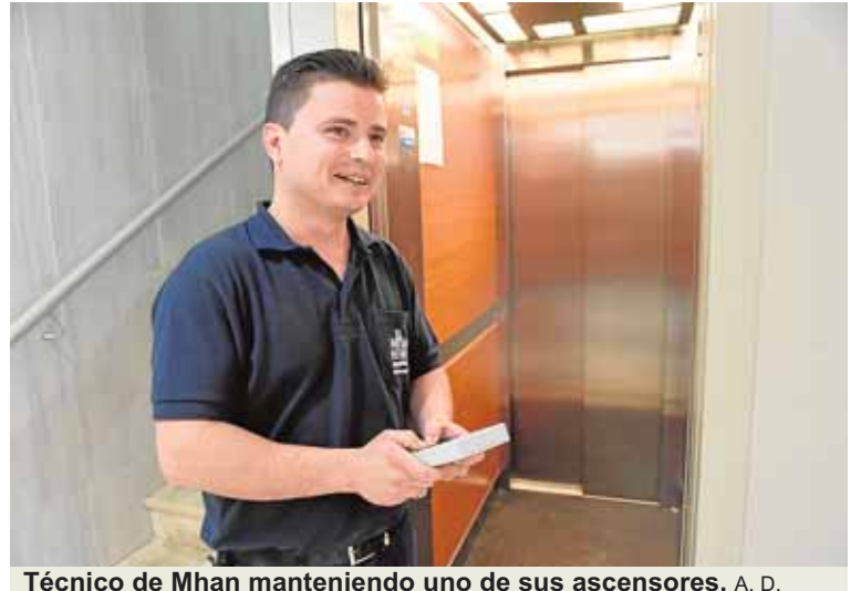
Técnico de Mhan manteniendo uno de sus ascensores. A. D.
